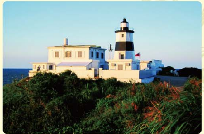
▲石門富貴角燈塔
